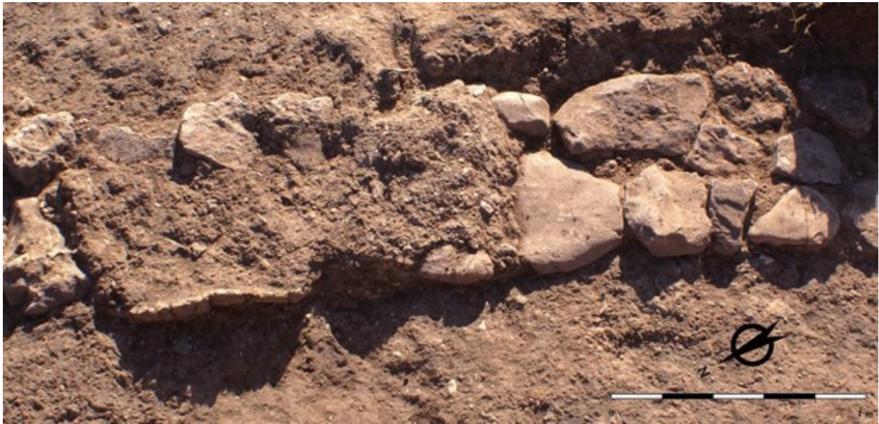
Figura 11. Muro M11003, detalle de la cubrición con mortero y del revoque
