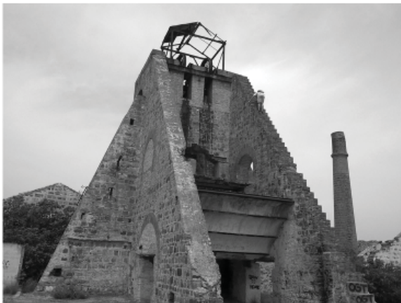
Figura 1. Cabria de mampostería construida con sillares de piedra y coronada por castillete metálico en el distrito minero de Linares-La Carolina (Jaén, España).
