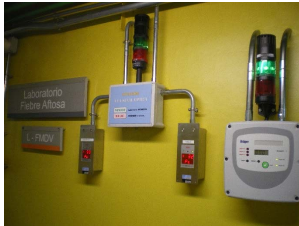
Figura 13: Alarma fallo sistema presión negativa (Autorizado CISA, Valdeolmos (Madrid))
