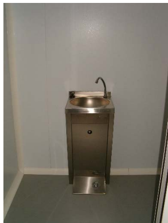
Figura 19: Lavabo con mecanismo de accionamiento con el pie (Autorizado Universidad de Jaén)
