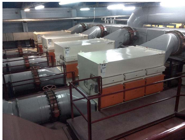
Figura 14: Cajón de filtros HEPA (Autorizado CISA, Valdeolmos (Madrid))
