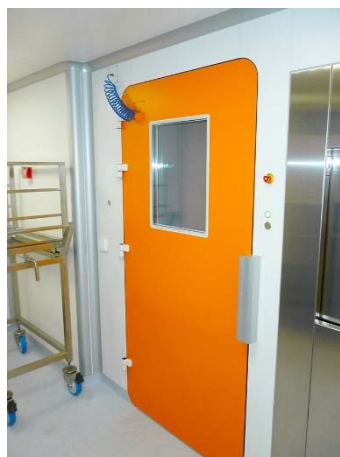
Figura 5: Puerta neumática estanca ( http://ingelyt.com/wp-content/uploads/2014/07/hermeticas_thumb1.jpg )
