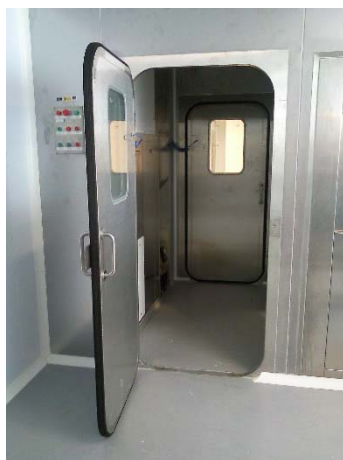
Figuras 17 y 18: SAS para paso de materiales con sistema de descontaminación con peróxido de hidrogeno (Autorizado Universidad de Jaén)
