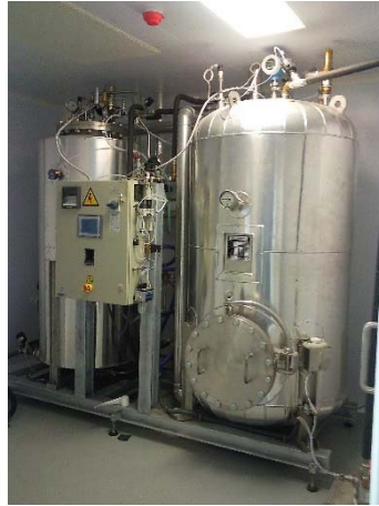
Figura 23: Tratamiento térmico efluentes (Autorizado Universidad de Jaén)
