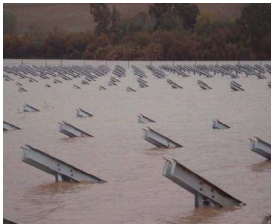
Figura 1: Siniestro por desbordamiento de río (montaje instalación solar fv)
