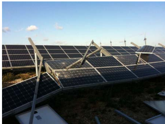
Figura 4: Siniestro por error en tornillería (montaje instalación solar fv)
