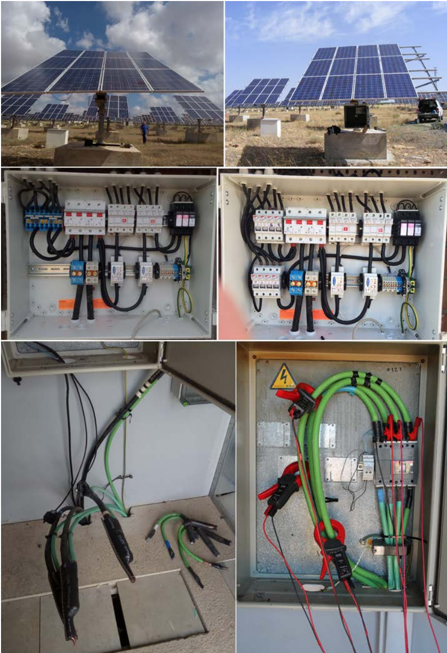
Figura 2.5 – Detalle de los trabajos de acondicionamiento realizados a la planta inicial (izquierda) y sus resultados finales (derecha)
