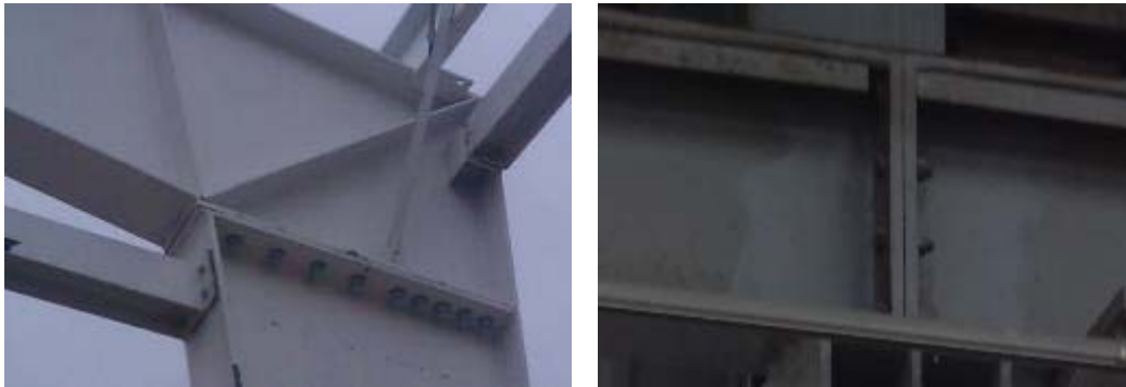
Figura 1 Conexiones empernadas en estructuras metálicas
